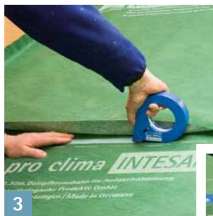
Dans le système pro clima INTESANA connect, le collage des chevauchements se fait avec les deux zones autocollantes intégrées. Les chevauchements des lés pro clima INTESANA ainsi que les joints aux extrémités se collent à l'aide du ruban adhésif double face pro clima DUPLEX, ou des adhésifs simple face TESCON No.1 ou TESCON VANA. Bien frotter les rubans pour qu'ils adhèrent au support, p. ex. à l'aide de la spatule de fixation pro clima PRESSFIX.
