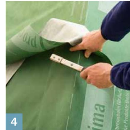
Centrer une bande du lé INTESANA d'une largeur d'env. 40 cm sur le faîtage. En agraffer les bords. Ensuite, réaliser le collage étanche à l'air à l'aide du ruban adhésif TESCON No.1 ou TESCON VANA. Recouvrir également les agrafes de ruban adhésif. Bien frotter les rubans pour qu'ils adhèrent au support.
