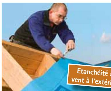
Etanchéité au vent à l'extérieur
