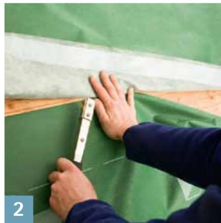
Veiller à un chevauchement des lés sur 8 à 10 cm, afin de garantir l'écoulement de l'eau. La fixation au niveau du chevauchement des lés se fait à l'aide d'agrafes distantes de max. 10 à 15 cm.
