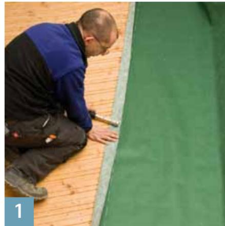
S'il y a des noues, dérouler d'abord la membrane en cet endroit, puis en replier et agraffer le bord. Au niveau de la surface du toit, poser les membranes parallèlement au pied de versant.
