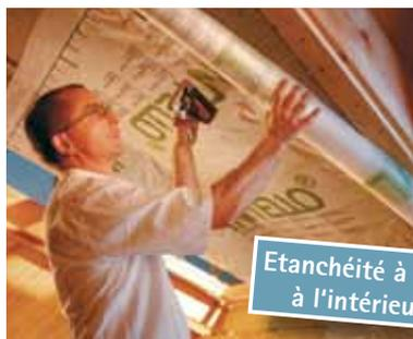
Etanchéité à l'air à l'intérieur
