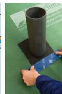
**Raccords rapides et fiables au niveau des passages de conduits et de câbles**
