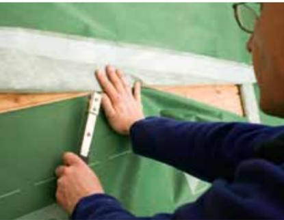
Frein-vapeur haute performance, résistant aux intempéries, pour isolations sur toiture, avec valeur  $s_d$  hydrovariable.
