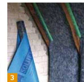
3 Fixer l'écran sur les côtés, à l'aide du lattage. Alternative : utiliser des languettes en fibres dures ou multiplex de 3 mm. Garantir l'écoulement de l'eau par-dessus la jambette jusqu'au pied de versant.
