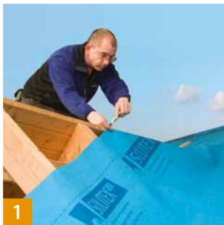
Mettre l'écran en place, parallèlement au pied de versant, avec la face bleue tournée vers le haut. Au niveau des noues : poser un écran de sous-toiture le long de la noue, en parties égales sur les deux versants.
