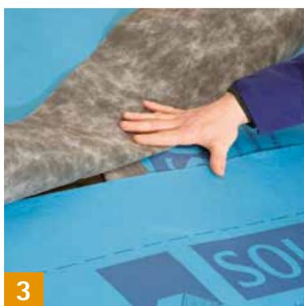
Respecter un recouvrement des lés de 10 à 15 cm. La fixation des écrans se fait à l'abri de l'humidité dans le tiers supérieur de la zone de chevauchement du lé suivant et sous le contre-lattage. Utiliser des agrafes galvanisées (d'au moins 10 mm de large et 8 mm de long). La fixation ne peut pas se faire dans des zones d'écoulement d'eau (p. ex. au niveau des noues).
