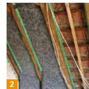
2 Mettre en place SOLITEX compartiment après compartiment, dans le sens longitudinal ou transversal. Veiller à ce que le chevauchement draine l'eau.
