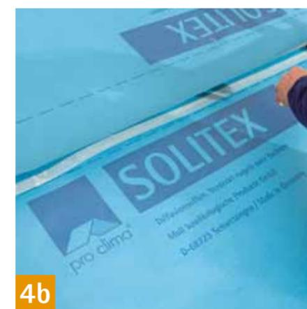
Le collage des chevauchements de lés SOLITEX MENTO connect et UD connect se fait de manière fiable, colle contre colle, grâce aux deux zones autocollantes intégrées. Les deux films transfert se laissent détacher d'un seul coup.
