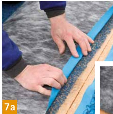
Pour les collages au niveau des joints aux extrémités, détacher la couche 3D en fibres liées-filées du lé inférieur sur une largeur d'env. 10 cm, puis la recouper sur env. 4 à 5 cm. Mettre l'écran en place et le fixer dans la zone de chevauchement. Détacher la couche en fibres liées-filées de l'écran supérieur, sur une largeur de 4 à 5 cm.
