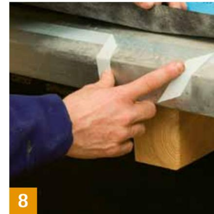
Raccorder SOLITEX UM connect au pied de versant de manière à ce qu'il draine l'eau. Pour cela, amener le lé sur une tôle ou une bande du pied de versant. A l'aide du ruban adhésif double face pro clima DUPLEX, coller l'ensemble en évitant les plis.
