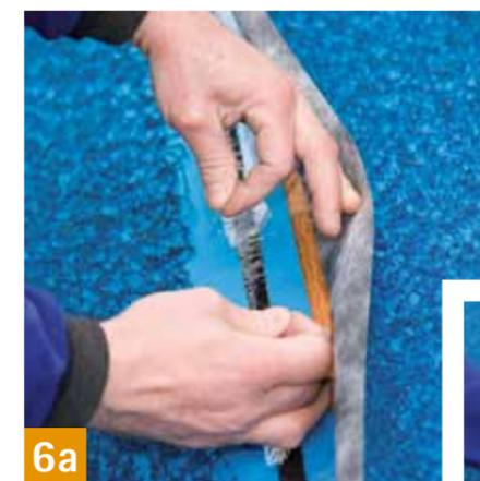
Plier le second lé vers le haut, détacher le film transfert et coller les deux lés ensemble, au fur et à mesure, à l'aide des zones autocollantes intégrées.
