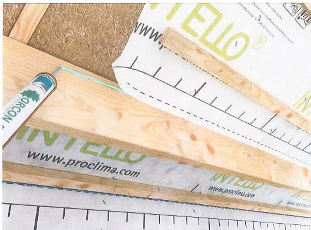
**Fig. A 17 : Raccord à une panne intermédiaire à l'aide de la colle de raccord ORCON CLASSIC/ORCON F**
