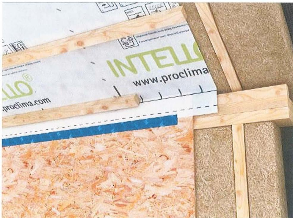
**Fig. A 16 : Raccord au mur de pied-droit dans la construction à ossature en bois à l'aide du ruban adhésif pro clima TESCON No.1/TESCON VANA**
