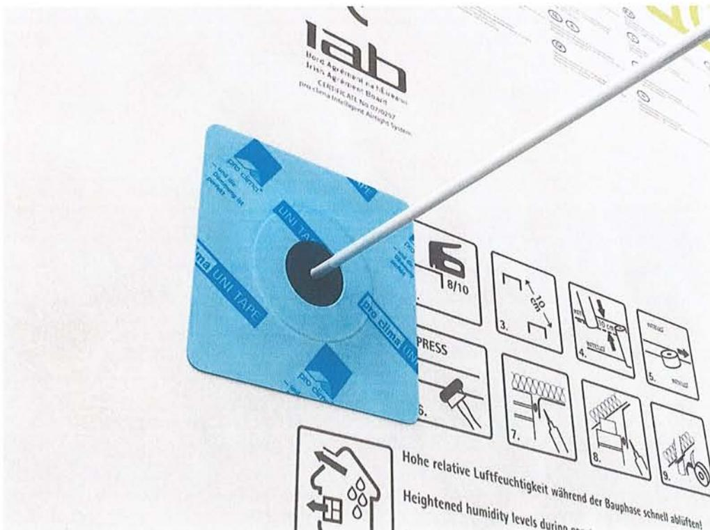
**Fig. A 18 : La manchette KAFLEX/ROFLEX 20 est à coller avec le ruban adhésif de la manchette sur la membrane INTELLO ou INTELLO PLUS**
