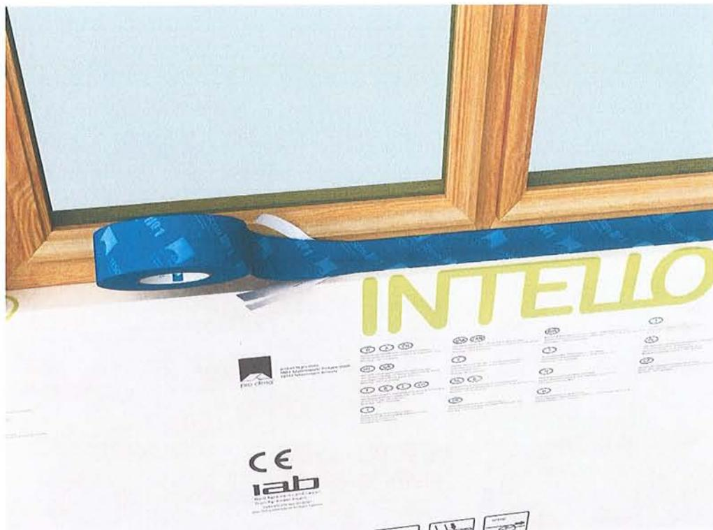
**Fig. A 15 : Raccord à une fenêtre avec TESCON PROFIL**
