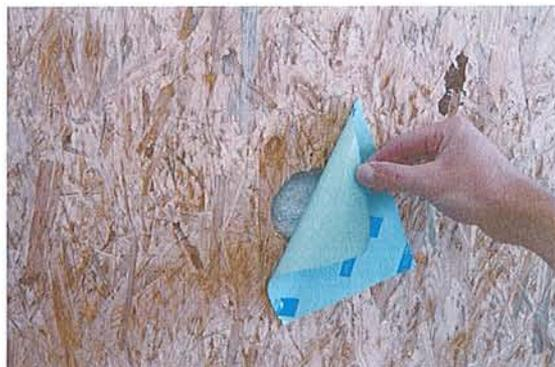
fig. 1 : Colmatage des « ajoures » d'insufflation
