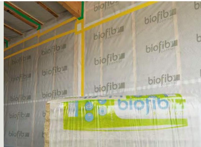
La gamme d'adhésifs Biofib' est spécialement conçue pour répondre aux exigences liées à la pose du frein vapeur Biofib' control. Chaque adhésif est adapté à un usage particulier : jaune pour le recouvrement des lés, vert pour le collage du frein vapeur sur tous types de support, marron «double face» pour la fixation de Biofib' control sur l'ossature (bois ou métal).
